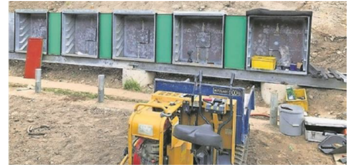
Die Kugelfänge des 25/50-m-Schiessstandes AeschiSO wurden saniert. Bild: zvg
